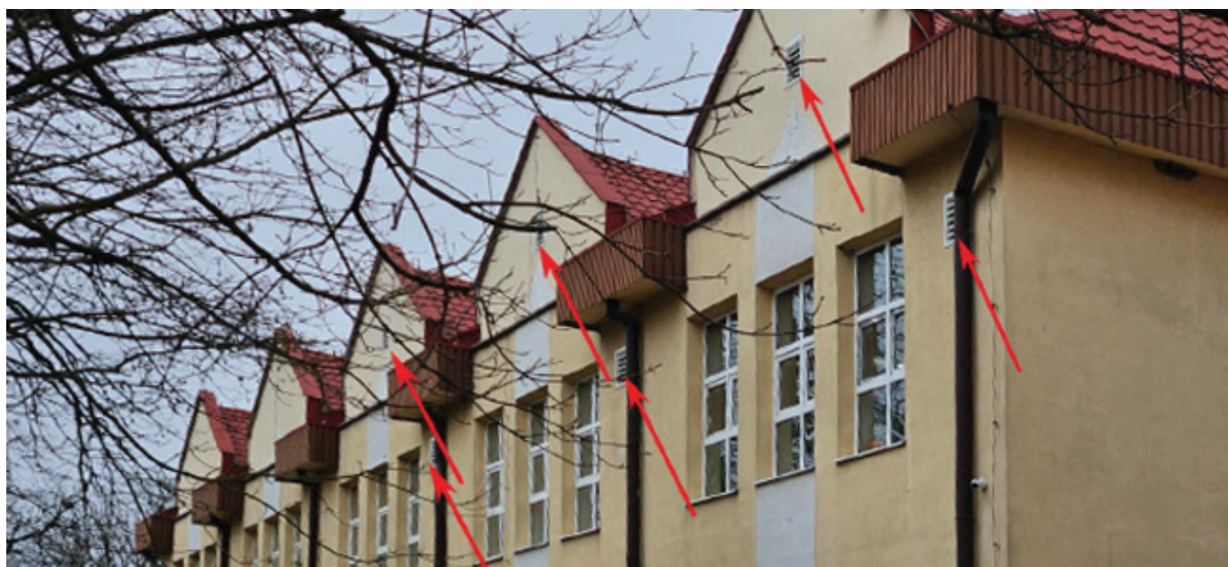
Elewacja szkoły w Niepołomicach z zamontowanymi czerpniami i wyrzutniami powietrza, które zaznaczono czerwonymi strzałkami
