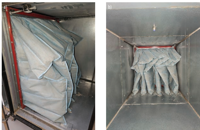
Kieszeniowy filtr powietrza: a – powierzchnia boczna, b – powierzchnia filtracji
