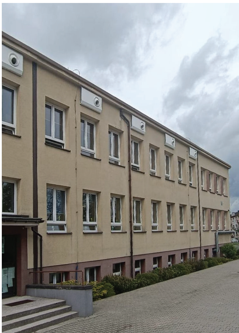
Widok elewacji szkoły w Lędzinach z zamontowanymi czerpnio-wyrzutniami powietrza
