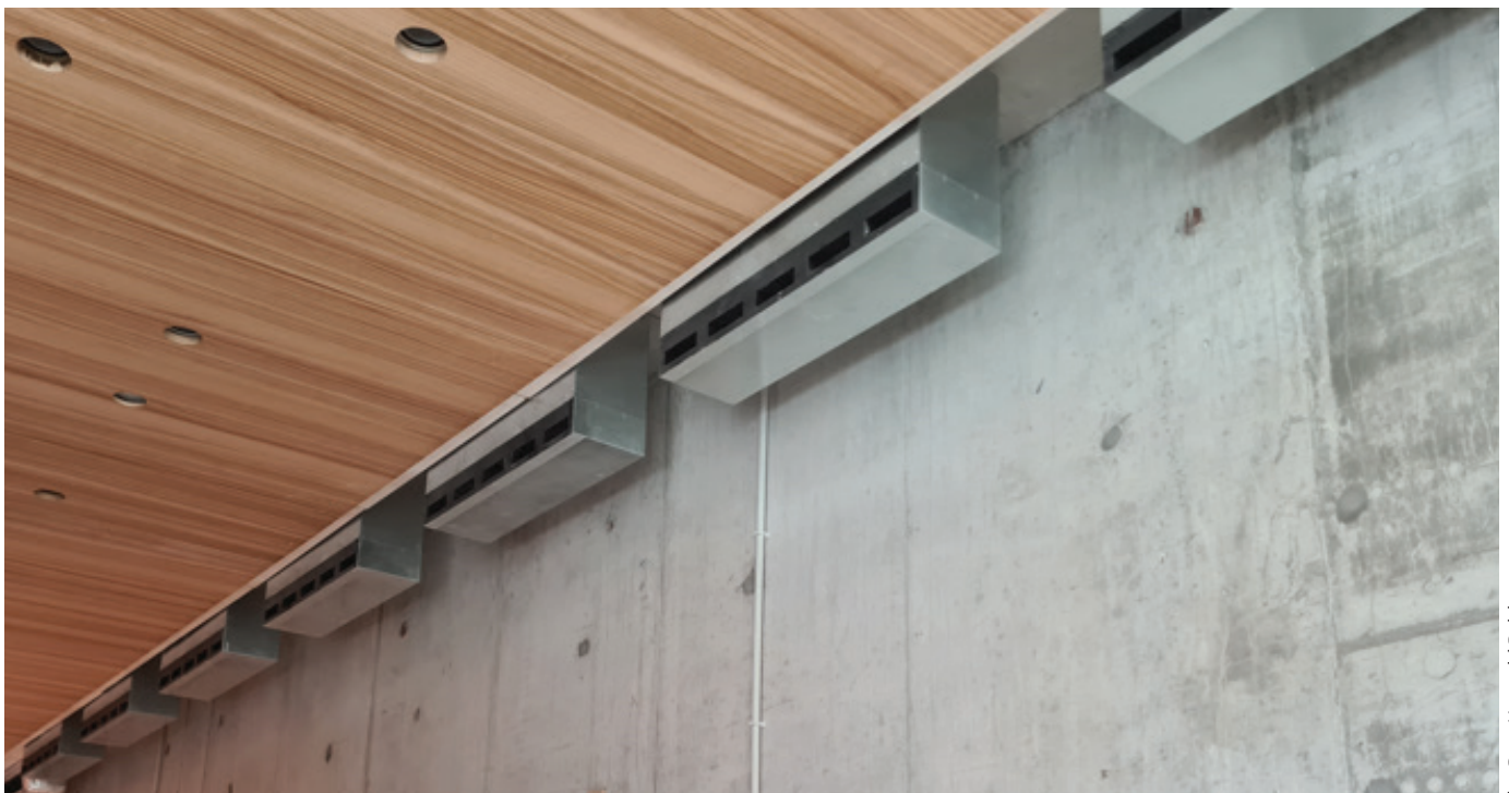
Nawiewniki zamontowane w pomieszczeniu czytelnicy
