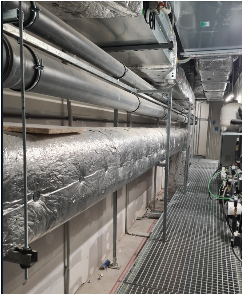
Instalacje HVAC rozprowadzone w przedściankach galerii
