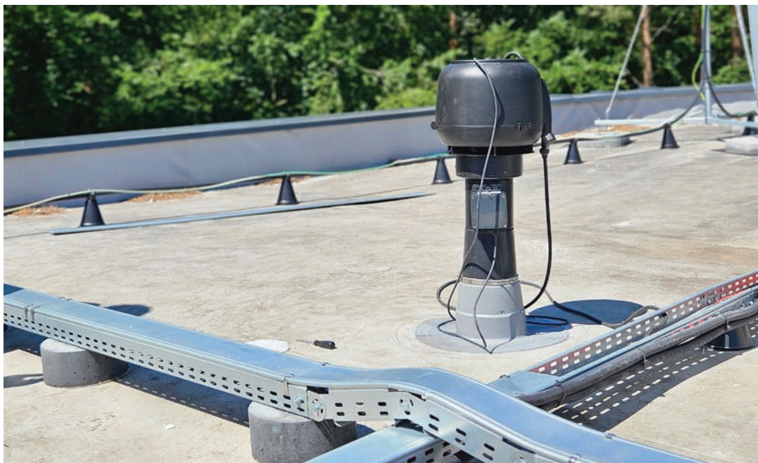
Inteligentna wentylacja współpracuje z nowoczesnymi systemami monitorowania i automatycznie dostosowuje intensywność przepływu powietrza do aktualnych potrzeb
