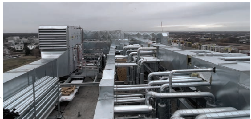
Dach szpitala po modernizacji z widocznymi kanałami wentylacyjnymi
