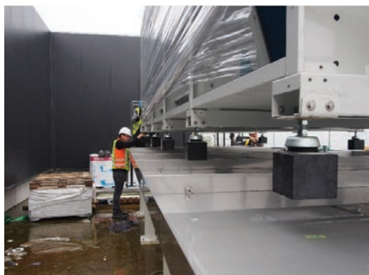
Fot. 3. Montaż dry-coolera
