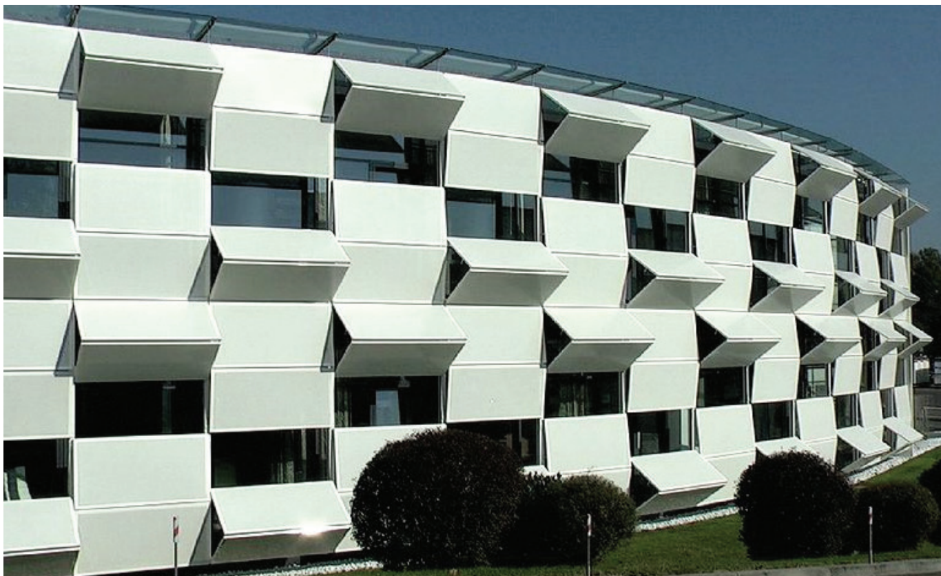
Dynamiczna fasada z elementami zaciernającymi kontrolowanymi przez użytkowników, salon wystawowy Kiefer Technic autorstwa Ernsta Gieselbrechta + Partnera, Steiermark w Austrii – działanie polega na elektronicznym sterowaniu każdym z 54 silników umieszczonych w fasadzie, źródło https://www.arch2o.com/dynamic-facades-the-story/
