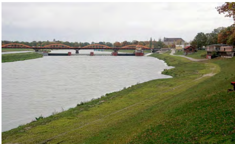
Poszerzone koryto Starej Odry o około 30m w celu zwiększenia przepływów.
