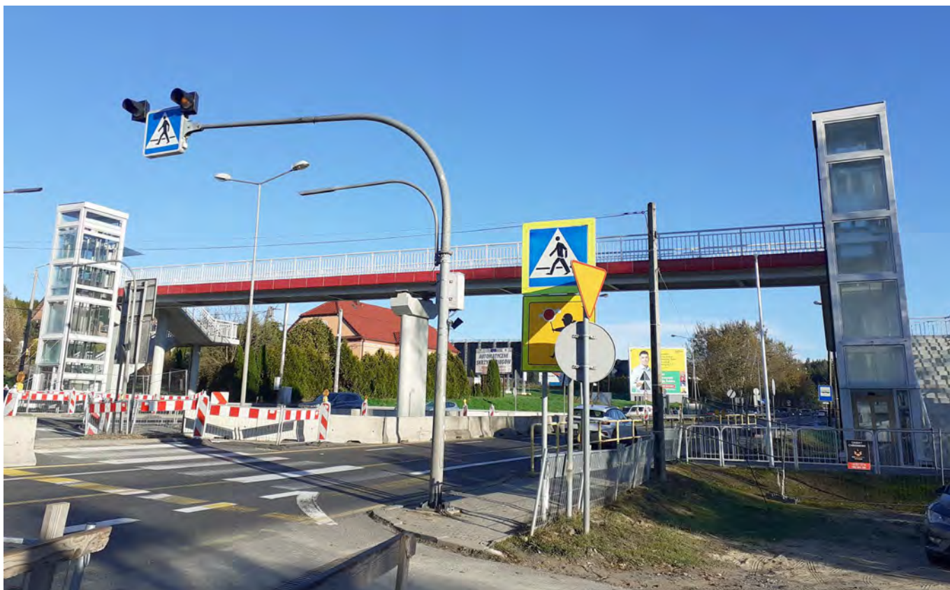
Kładka w Mogilanach
