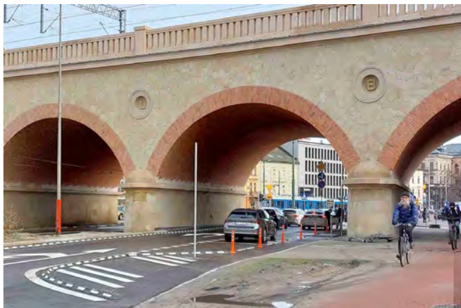
Wiaduktu kolejowego nad ul. Grzegórzecką w Krakowie
