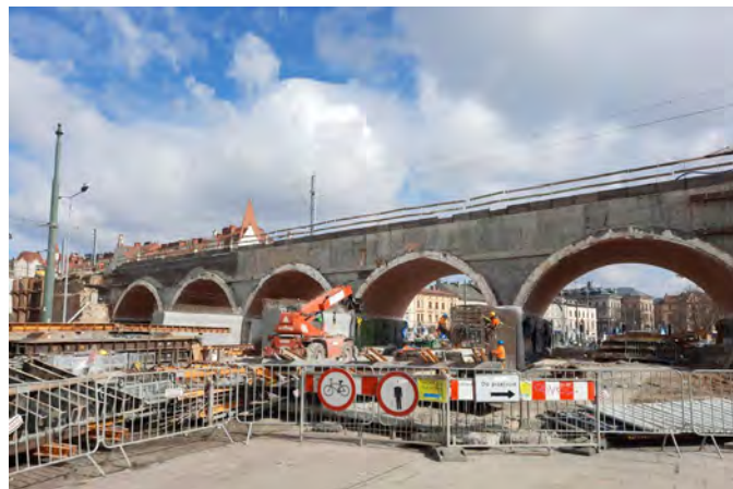
Budowa wiaduktu kolejowego nad ul. Grzegórzecką w Krakowie
