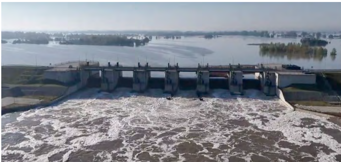
Zbiornik Racibórz Dolny w trakcie pietrzenia
